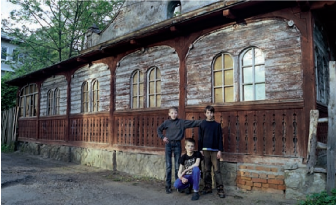
Budynek Łazienek, stan z kwietnia 2016 r.
