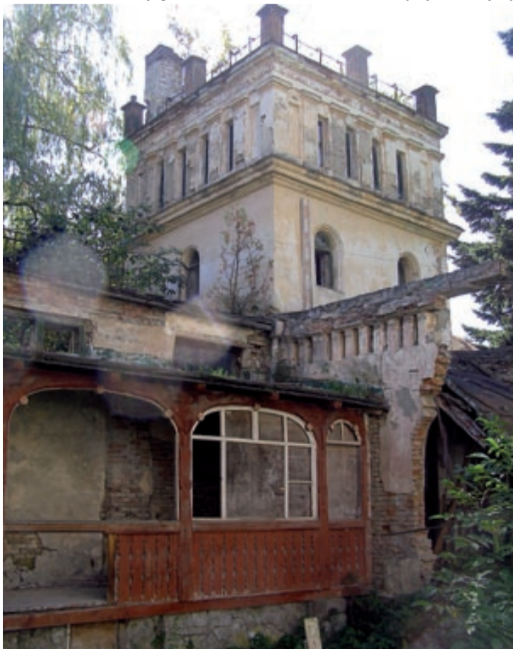
Łazienki od strony północnej, 2012 r.
