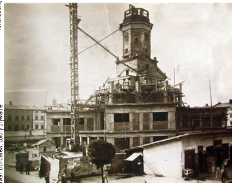
Czwarty ratusz w budowie
