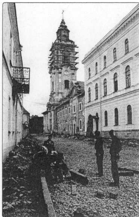
Prace restauratorskie w Kamieńcu Podolskim.
